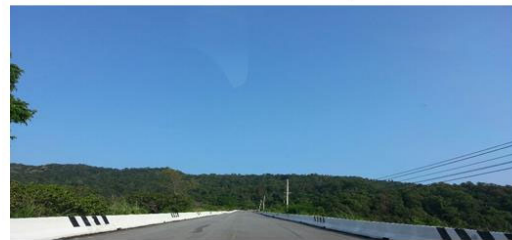
ถนนลอยฟ้าช่วง อ.เมือง - อ.บ้านหลวง
