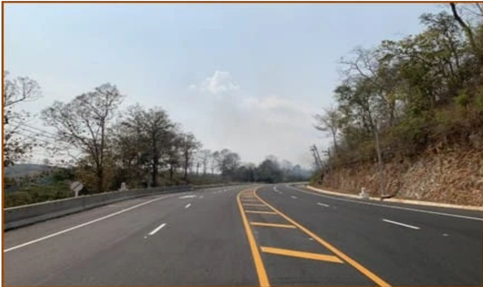
ภาพที่ ๒-๒๑ ทางหลวง ๑๐๒๖ ช่วงอำเภอเวียงสา มีการก่อสร้างเป็น ๔ ช่องจราจรแล้วตั้งแต่ปี ๒๕๖๓
