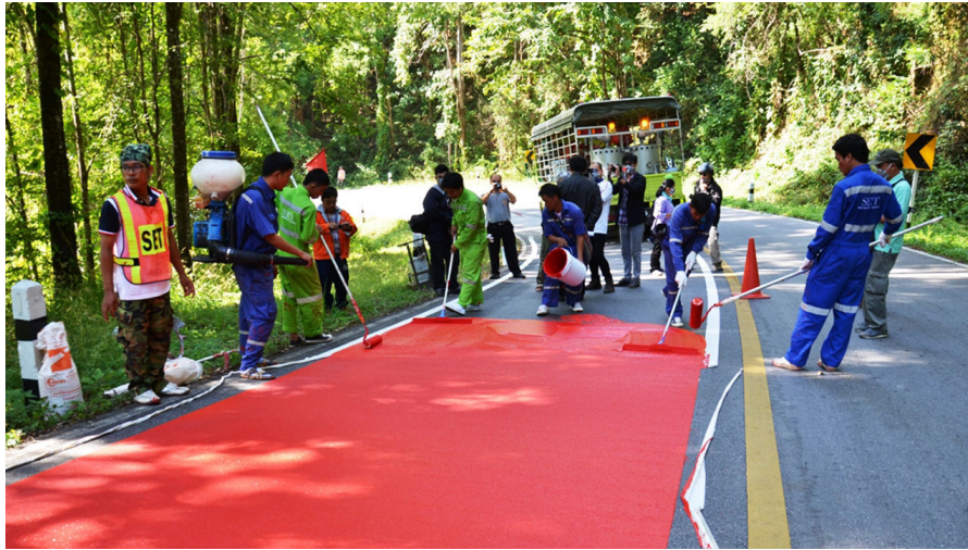
ภาพที่ ๒-๒๓ ทางหลวง ๑๖๘ เป็นถนนสายแรกของที่ทาสิกันสิ้นเพื่อสร้างความปลอดภัยในการขับขี่
